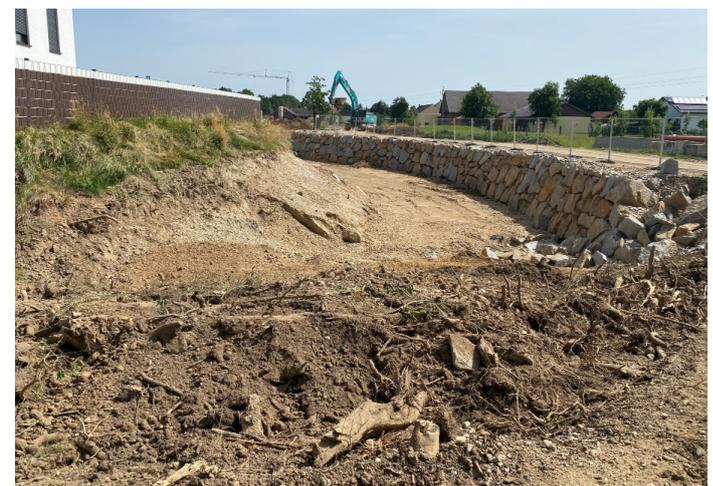
Steinschichtungen sorgen für die nötige Absicherung im Kurvenbereich.
